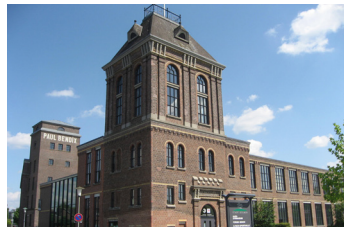
Ehemalige Spinnerei Bendix dient heute als Gymnasium
